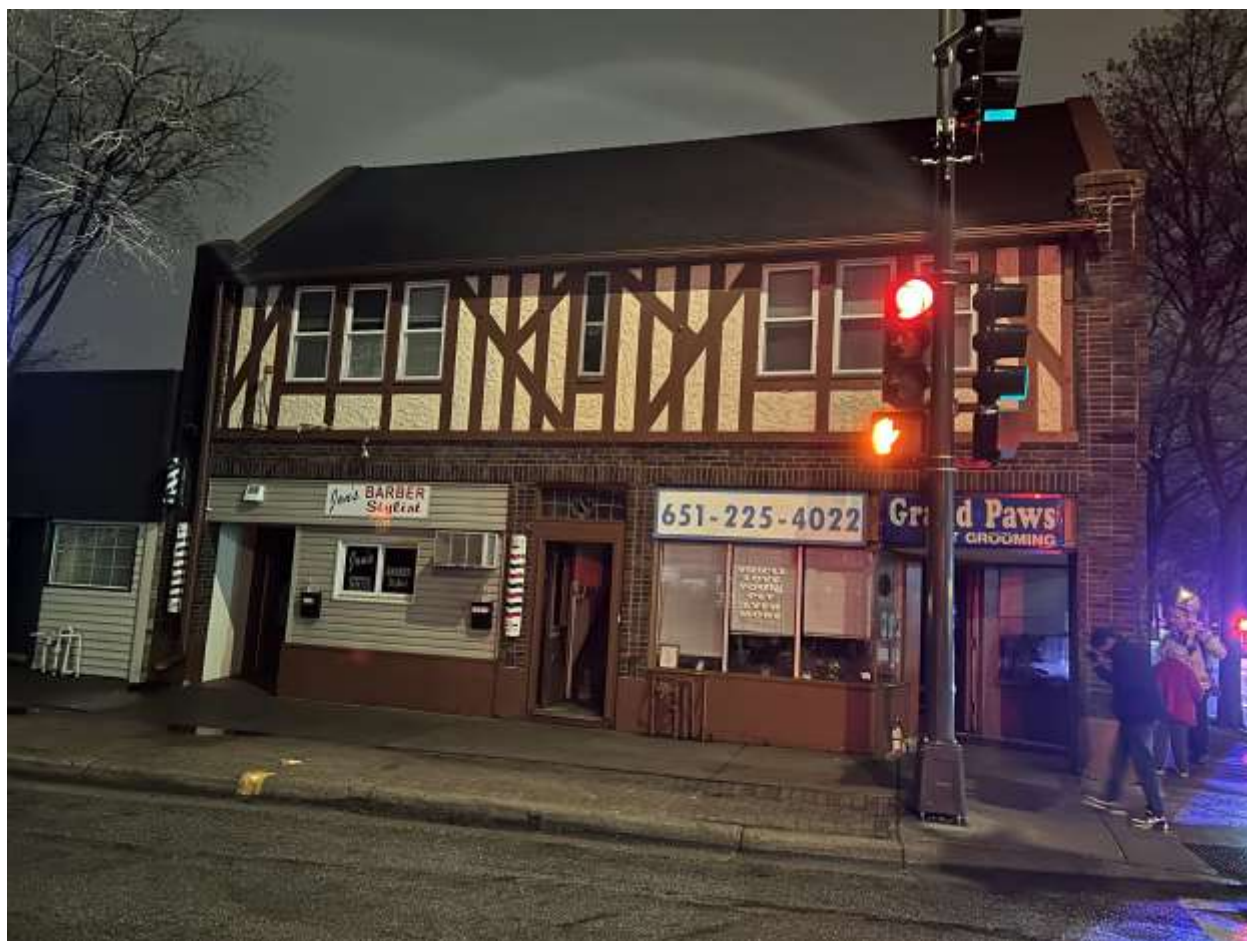
600 Hamline Ave N.Fire Photos
