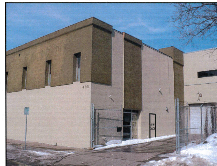
3 SE ELEVATION - PHOTO
