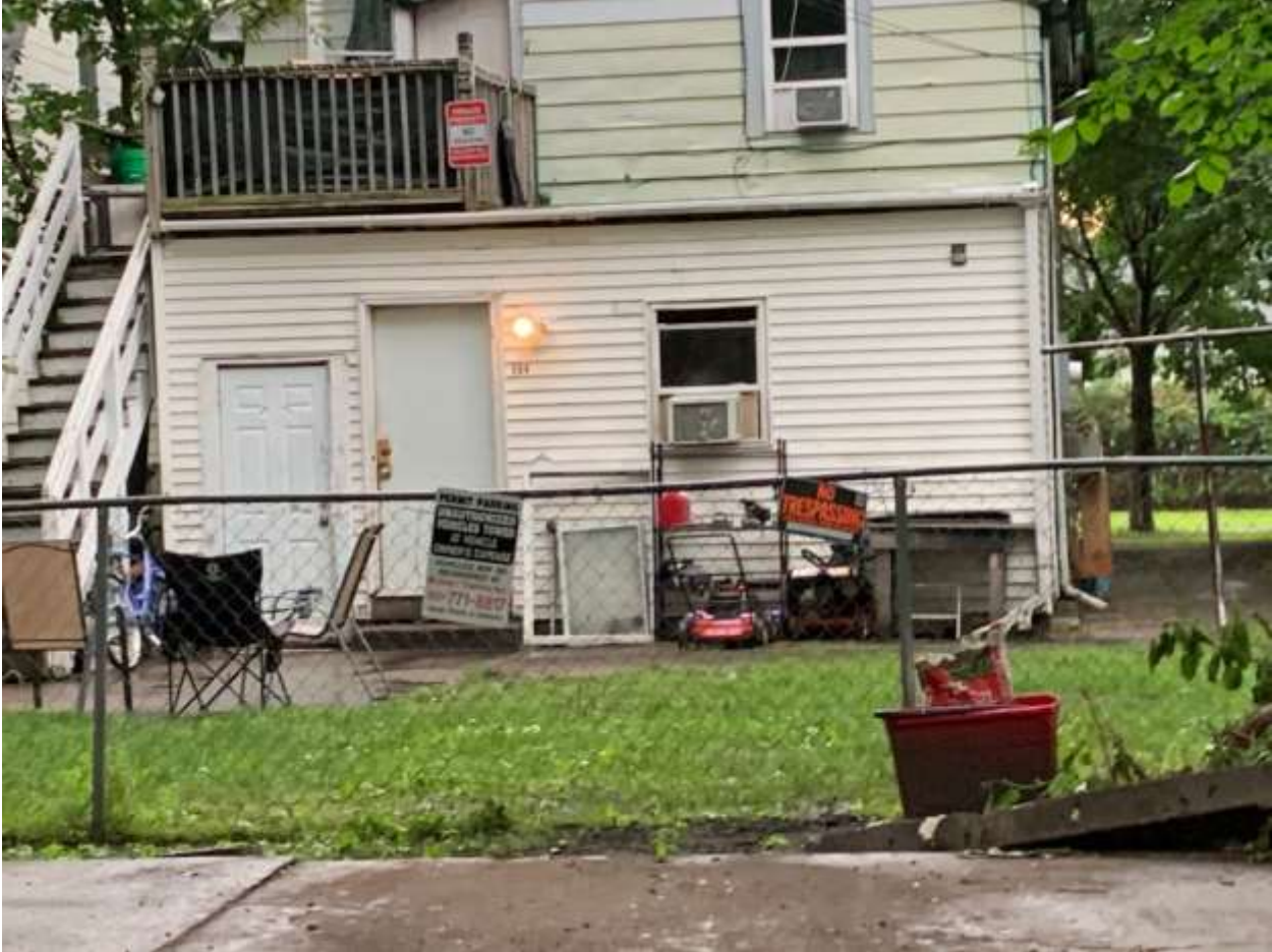
564 Blair Ave.rechecked photos 7-15-24
