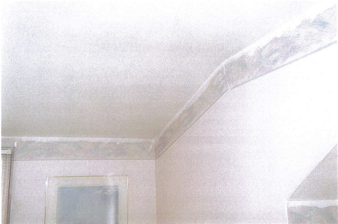
SE Bedroom Ceiling
