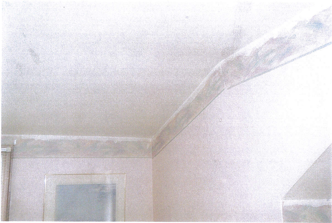
SE Bedroom Ceiling
