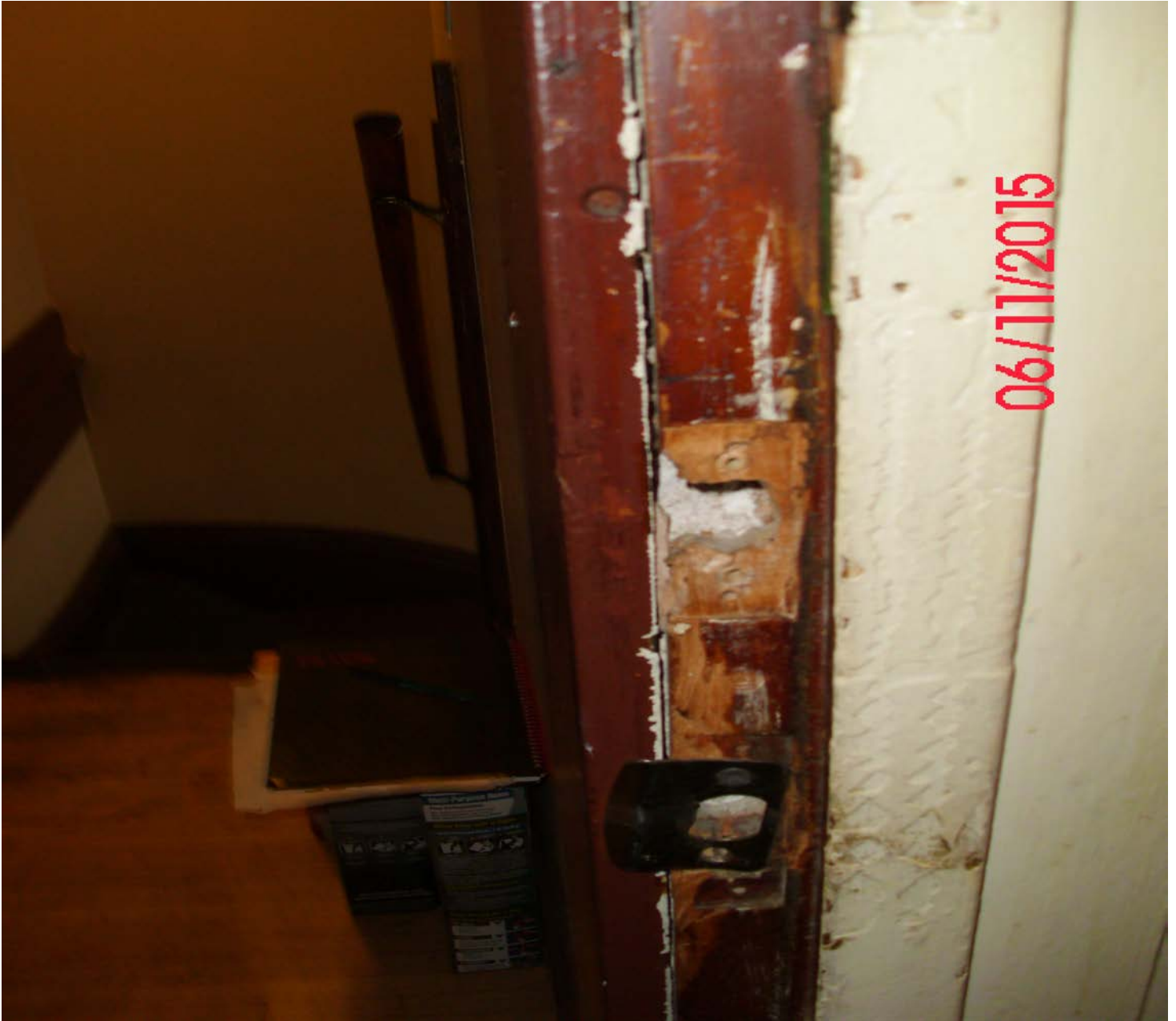
Unit entry door frame
